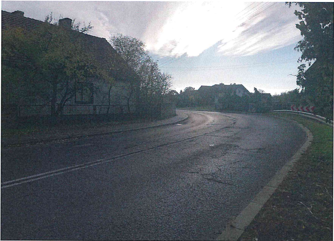
Zdjęcie nr 11 - widok z kierunku m. Nądnia w kierunku kościoła.
